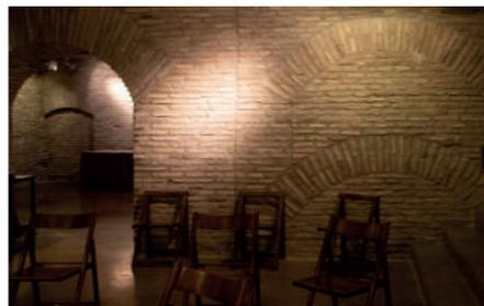
Detalle arcos ciegos de descarga de cimentación en muro de sótano
